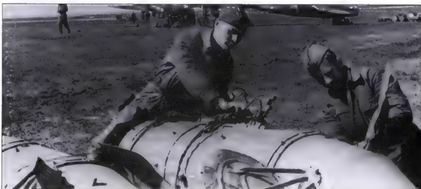
Varias divisiones de bombardeo estratégico fueron comprometidas en apoyo de la operación «Bagration», muchas de ellas equipadas con Ilyushin Il-4 como éstos. En primer plano, la unidad de amunicionamiento del regimiento prepara un dispensador de bombas de racimo RRAB-2 de 500 kilos, que contenía 66 bombetas AO-10.
